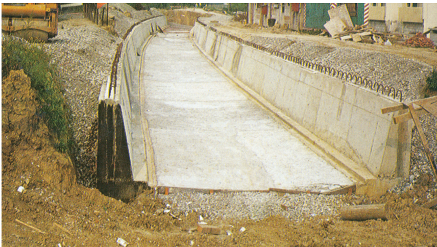
Novo korito jednoga bujičnog potoka (detalj naslovnice prospekta)
