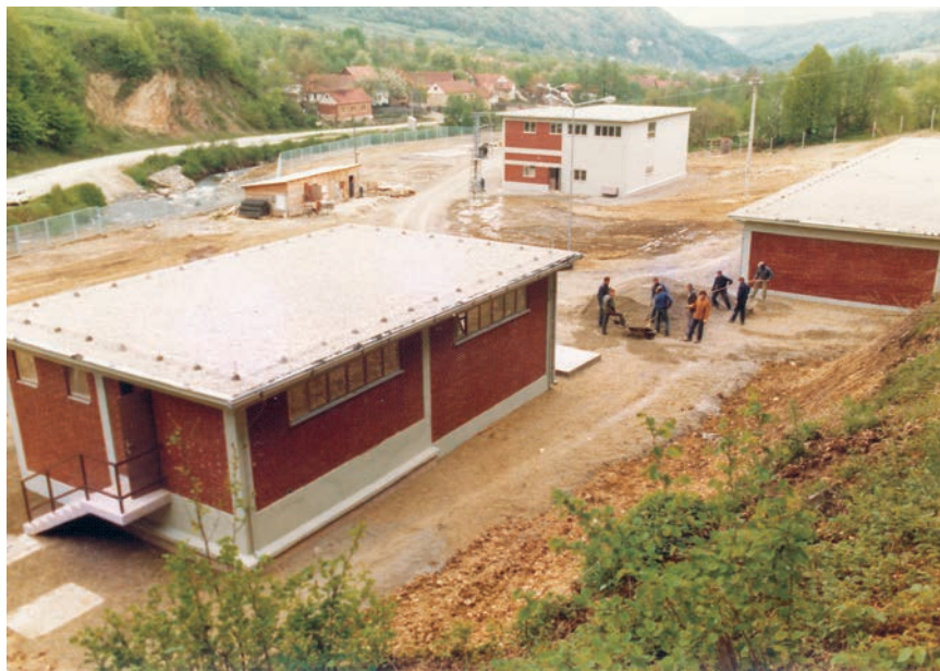
Detalj gradnje crpilišta Šumetlica kraj Pakraca 1977. godine (snimio: V. Vučevac)
